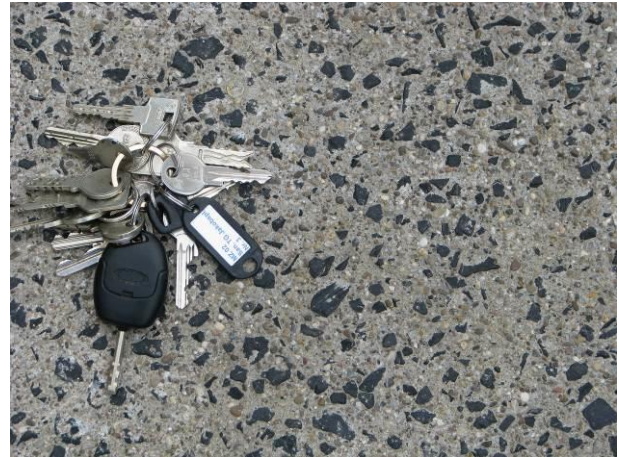
Bild 6: Waschbetontextur unter händischer Herstellung
