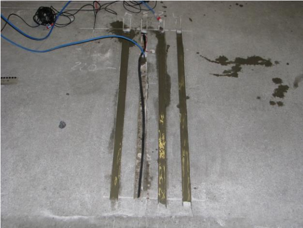
Bild 10: KKS-Probeaufbau entlang Rissen/ Sollbruchstellen mit massiven metallischen Einbauten (Höhenleeren) im Beton zur Ermittlung der KKS-Konfiguration
